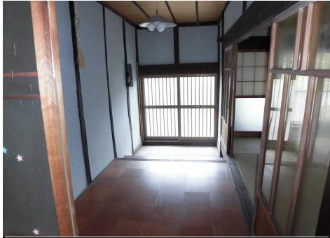
玄関・ホール
